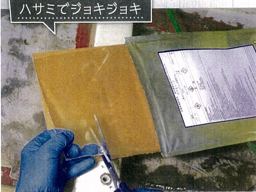
PPSシートはハサミで簡単に切り取ることができる。紫外線で硬化してしまうので、貼り付ける直前までアルミパウチにしまっておく。
