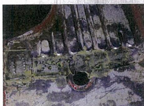
シートを貼り付けるためには専用のプライマーが必要だ。プライマーはビニルエスチル樹脂で、主剤100%に対して硬化剤を3~5%添加することで硬化する。この時、硬化剤の濃度を高くしてしまうと発火の危険があるので注意する。1g単位で計測ができるキッチンスケールを用意して、主剤を50g、硬化剤を2g添加して(4%の添加)よくかき混ぜ、ヘラなどでシートを貼り付ける部分に塗布する。プライマーは柔らかいので、刷毛で塗り込むほうが作業しやすいかも。
